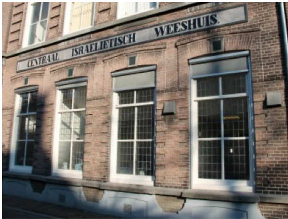
De beeldhouwer Richard Wendling heeft de nieuwe muurstenen ontworpen en gehakt, waarbij er naar gestreefd is zo dicht mogelijk bij het origineel te blijven.
