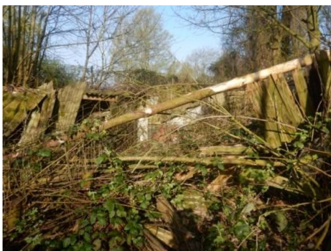
Door braam verruigde opstallen
