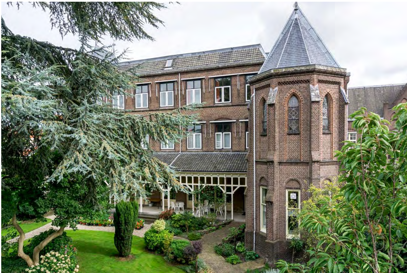
38. Klooster vanuit het zuiden, de ramen van de vensters op de verdiepingen boven de veranda zijn in 1990-1991 vervangen, maar niet naar authentiek model, 2017 ( www.persberichten.deperslijst.com : persbericht van SOM juli 2019; met dank aan de heer C. Verboom en de heer E. Groenewold). Het dak van de veranda is belegd met (zeldzame) Utrechtse blauwe platte pannen.
