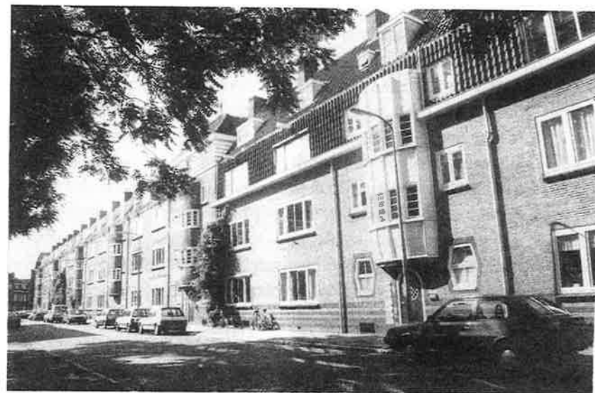
Afbeelding 25. De houten kozijnen zijn in 1980 vervangen door aluminium schuiframen.
