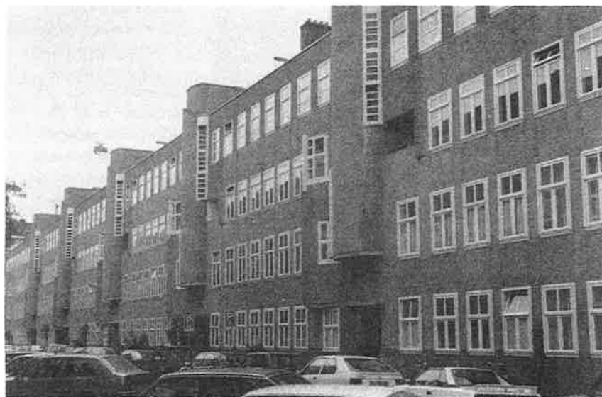
Afbeelding 13. Vergelijkbaar met de flatgebouwen van Het Nieuwe Woonhuis zijn deze flatgebouwen voor Woningbouwvereniging De Samenwerking aan de Bronckhorststraat in Amsterdam, gebouwd in 1922-1923. De architect is J.F. Staal. Hier wordt de ingang van de trappenhuizen benadrukt door een verticale uitbouw aan de gevel.
