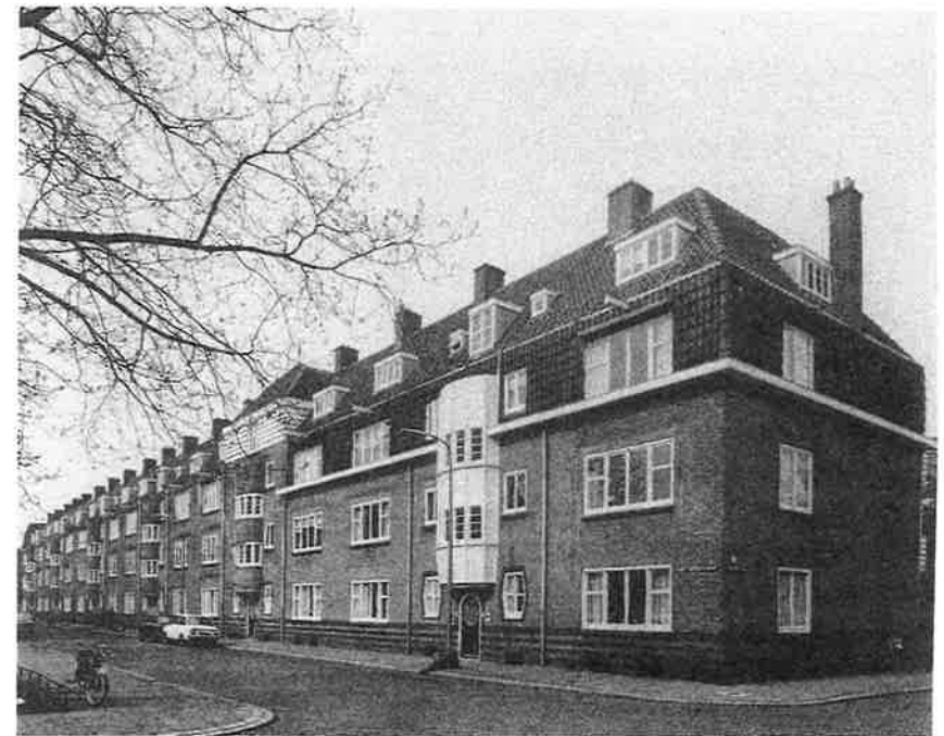
Afbeelding 15. De bordessen tegen de trappenhuisen geven de gevel een bijzonder accent. De bordessen op de hoeken van de complexen zijn in hout uitgevoerd.
