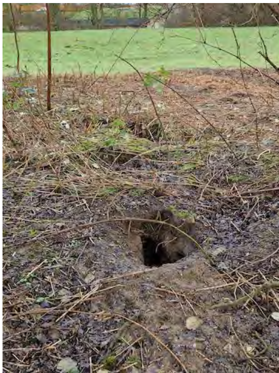
Figuur 3-9 Burcht Beatrixpark (zuid): begroeiing is hier recentelijk verwijderd, waardoor de burcht erg open is komen te liggen. Hier zou weer meer begroeiing rondom de burcht moeten worden aangeplant en afscherming (prikkeldraad?) moeten worden aangebracht om de burcht beter te beschermen tegen verstoring door mensen en honden. Eventueel ophogen van de plek met een bult zand is een optie (het Beatrixpark als geheel is relatief vochtig), maar dit gedeelte ligt toevallig relatief wat hoger, zoals al te zien is aan überhaupt de aanwezigheid van een burcht. Een hogere bult zand hier aanbrengen zou evenwel kunnen leiden tot een grotere burcht en dus meer konijnen.
